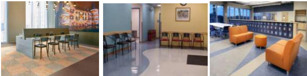
شكل (5) توضح استخدام مشمع الأرضية الطبيعي في الأماكن العامة مما يدل على قوة تحمله ومقاومته للبري والتآكل مع توضيح ألوانه وتأثيراته المختلفة ، وإمكانية عمل تصميمات مختلفة به فهو خامات ذات متانة عالية وتقاوم الحريق وتعيق سريان اللهب ، ومضادة
